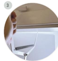
3 Öffne die Türrahmenklammer und positioniere sie mittig auf dem Türrahmen.
